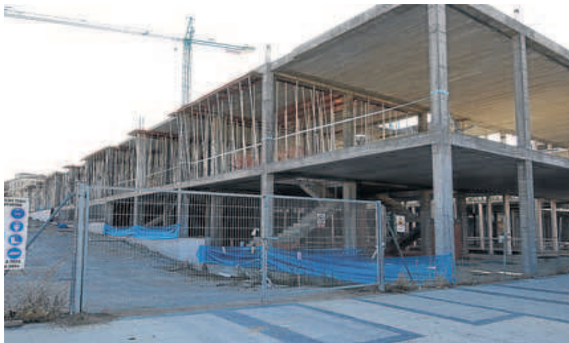
Obras de construcción del futuro Palacio de Justicia paralizadas. :: A. DE TORRE
